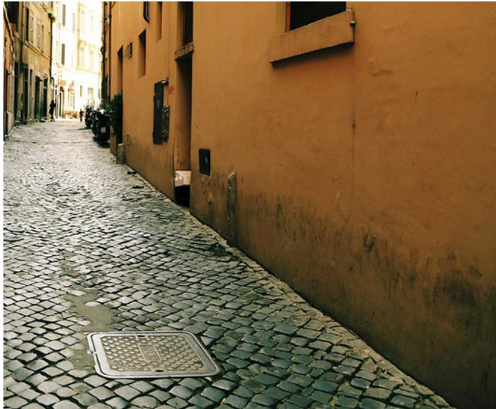
Eine Zugriffsöffnung ist ein unterirdisches Wartungsbauwerk, das typischerweise mit einem rechteckigen Deckel mit abgerundeten Kanten abgedeckt ist.
