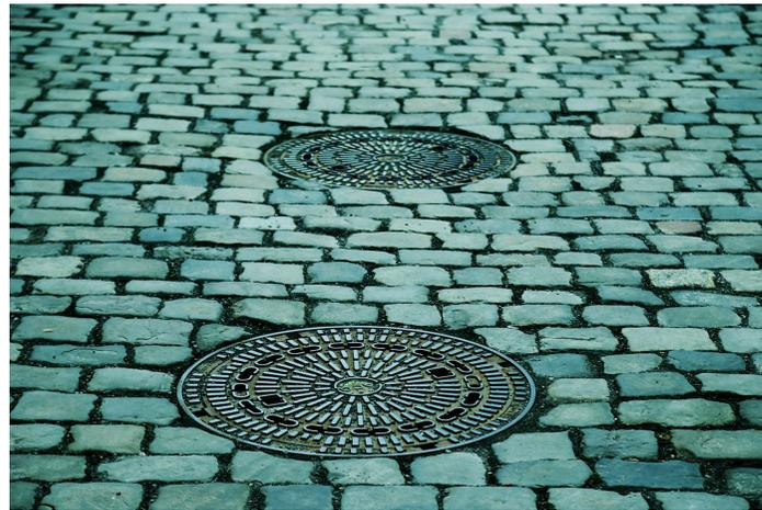
Als Schacht definieren wir bei Cyclomedia den Zugang zu einer unterirdischen (öffentlichen) Versorgungseinrichtung, der groß genug für eine Person ist und somit eine Inspektion und Wartung zulässt dieser unterirdischen Versorgungseinrichtungen zulässt. Der von uns für Sie bereitgestellte Datensatz bietet entsprechende GPS-Standorte (X, Y, Z) der extrahierten Objekte. Zusätzlich extrahieren wir außerdem den Typ des Schachtes.
